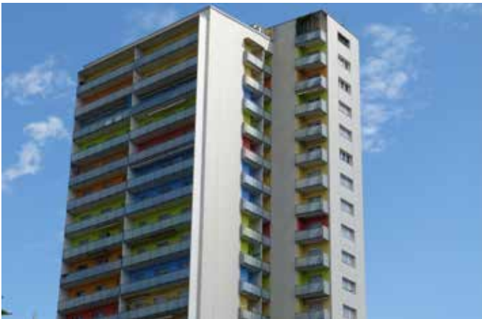
Wohnhochhaus der Nachkriegszeit in der Kärntnerstraße
