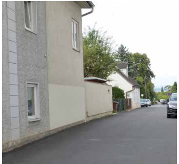
Nußbaumerstraße mit dem Bauplatz links, drittes Gebäude
