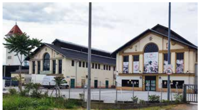
Obsthalle und Schlachthof in der Lagergasse
