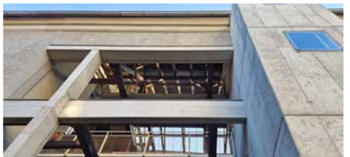
Sichtbare Holzkonstruktion und Dachstuhl im ehemaligen Mühlengebäude (2024 ET)
