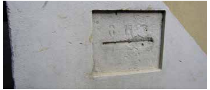
Westseitige Hochwassermarke von 1827 (Grazerbe)
