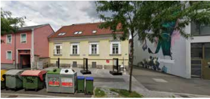
Ehemalige Eisengießerei Juhász in der Wienerstrasse 12 (Grazerbe)
