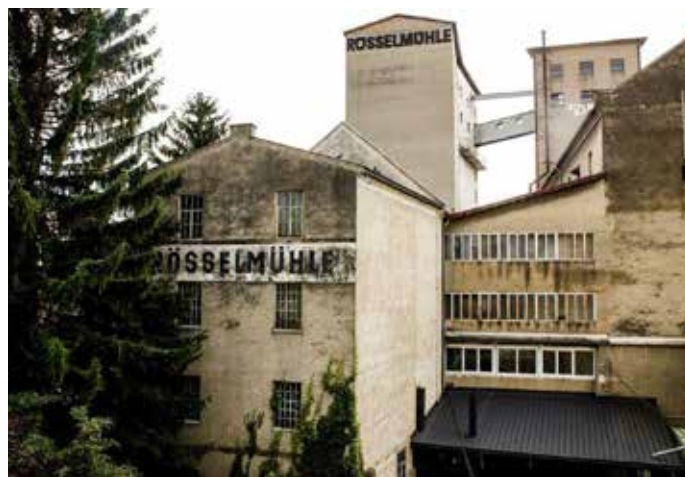
2019: Das Gebäude der Rollgerstefertigung vor dem Brand und Abriss 2023 (Foto: Stefan Pajman, Kleine Zeitung)
