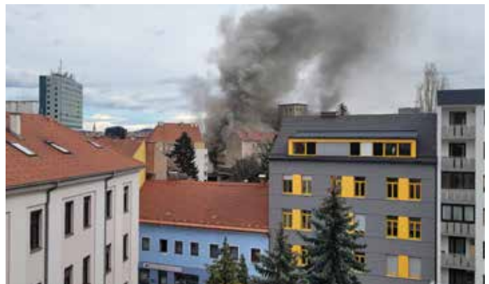
1. April 2023: ein Teil der Rösselmühle wird durch einen Brand schwer beschädigt (Foto: Mario Mastroianni)
