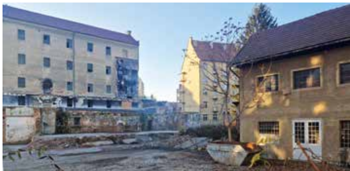
Nach dem Abbruch der beiden östlichen Silotürme und Mühlengebäude (Nov. 2024 ET)
