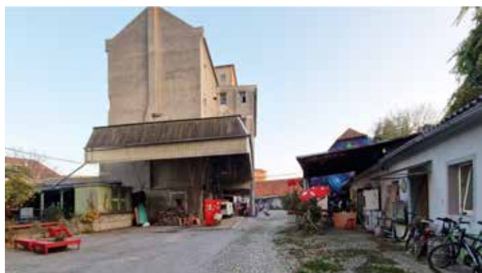
Blick in das Rösselmühlareal nach dem Abriss der beiden östlichen Silotürme und einiger Nebengebäude (2024 ET)
