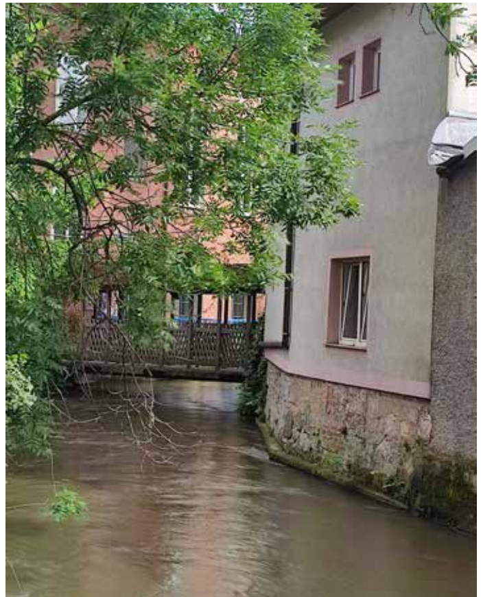
Mühlgang-Durchfluss beim Volkshaus (ehemalige Textilfabrik mit wechselvoller Geschichte) (2024)
