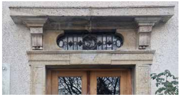
Eingangsportal des Verwaltungsgebäudes mit den Initialen des ehemaligen Besitzers (Nov. 2024, ET)
