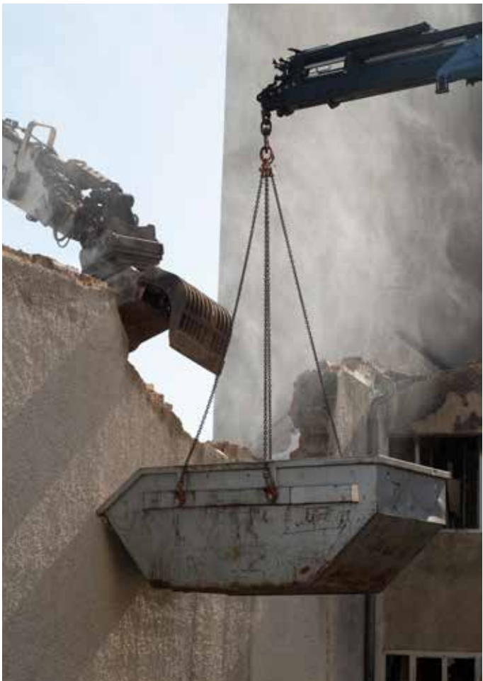
Abbruch der durch den Brand im April beschädigten Gebäu- deteile der Rösselmühle (23. Nov. 2023 Mark Angus)
