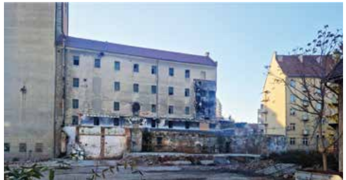
Nach dem Abbruch der östlichen Mühlengebäude und Silotürme der Rösselmühle im Jahr 2024 (30. Nov. 2024, ET)
