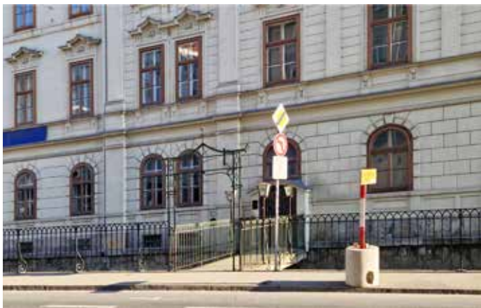
Ehemaliges Gasthaus im Bürgerspitalsgebäude mit Eingang über dem Mühlgang. Nur das geschmiedete Geländer steht unter Denkmalschutz. (2024 ET)
