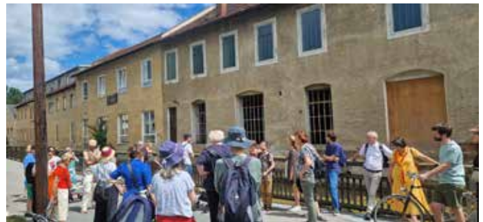
Die ehemalige Lederstampfe, später Puch-Fahrradwerke bei der Karlauerstraße (Abrissgenehmigung ist erteilt) während des Rundganges im Juli 2023 (ET)
