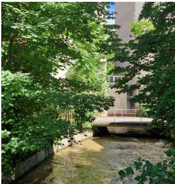
Das Durchfließen des Mühlgangs unter der Rösselmühle, 2023 noch mit den drei Silotürmen (ET)
