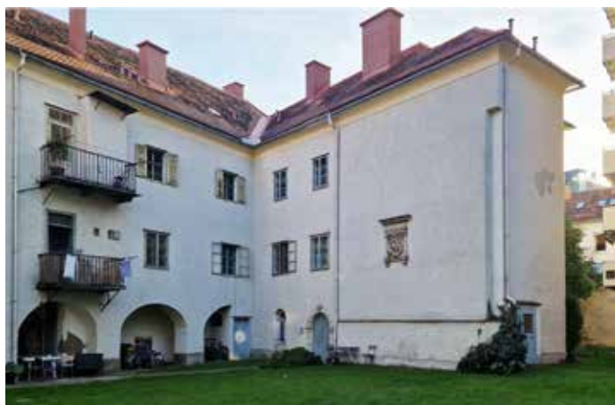
Innenhof Bürgerhospital (2024 ET)
