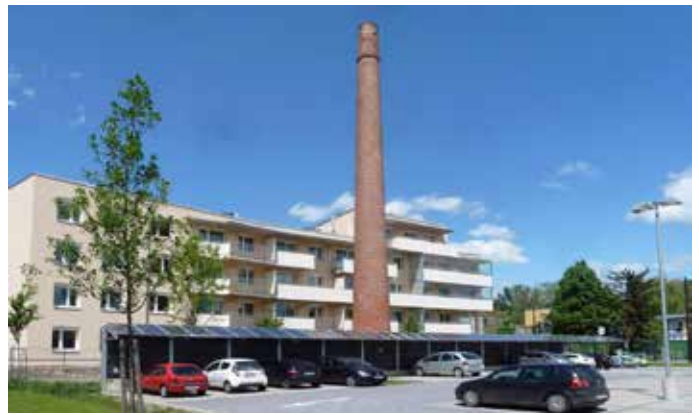
Der erhaltene Fabriksschlot in der Floßlendstraße als letzter Hinweis auf die ehemalige Dampfwäscherei Helios (Foto: Strobl Bau)
