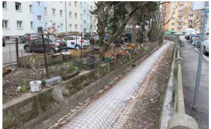
Liebevoll genutzter Erholungsraum entlang des Schleifbaches, hier während der Sanierung 2018 (ET)
