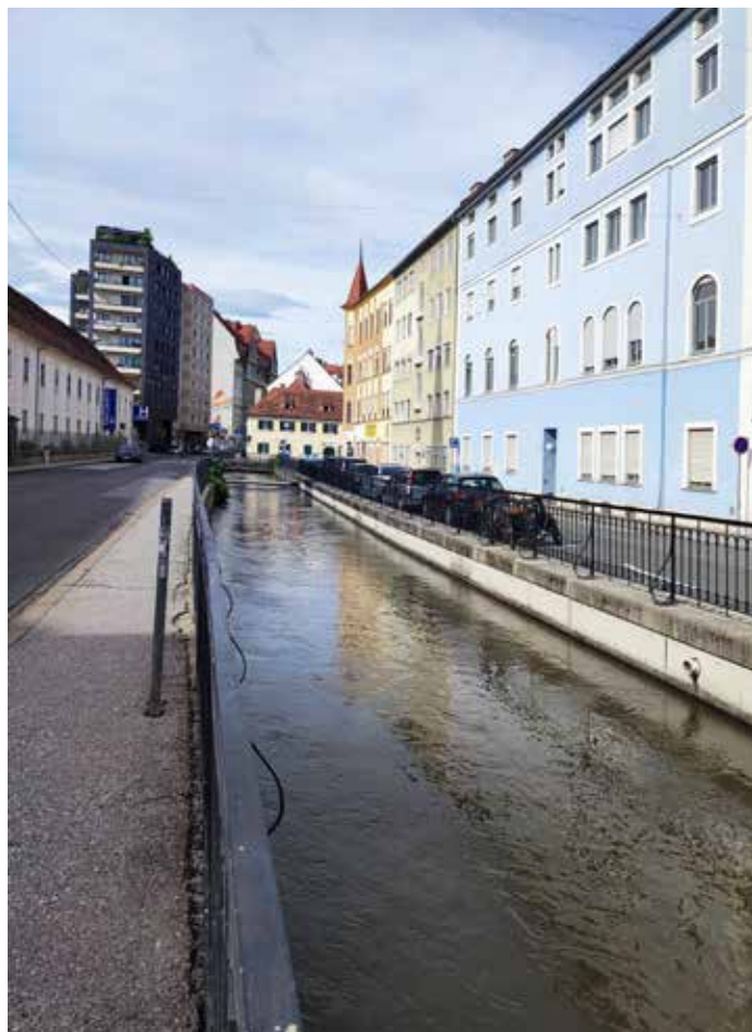
Der Mühlgang an der Elisabethinergasse, Blick Richtung Norden (2024 ET)
