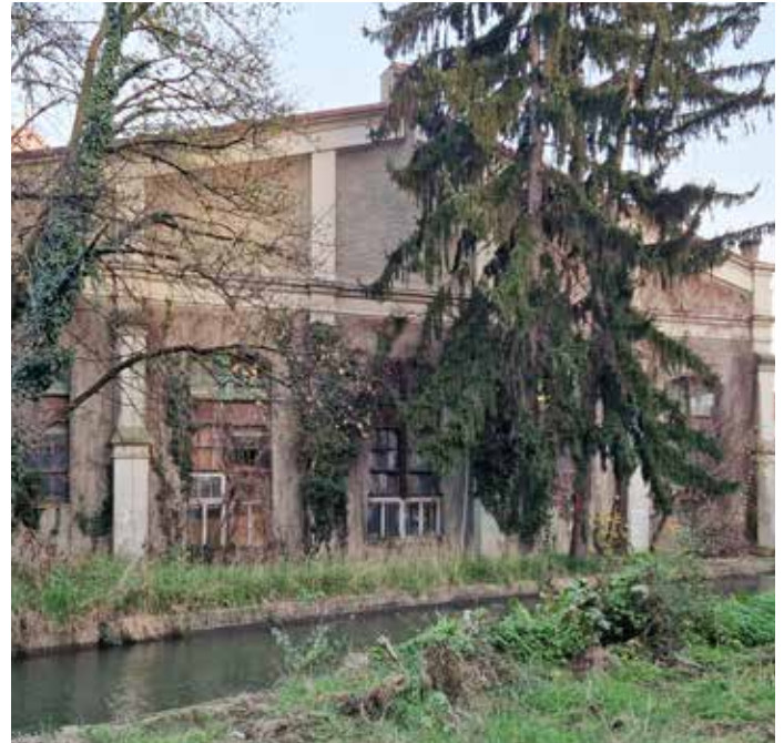
Denkmalgeschütztes Gebäude der Postgarage (2024 ET)
